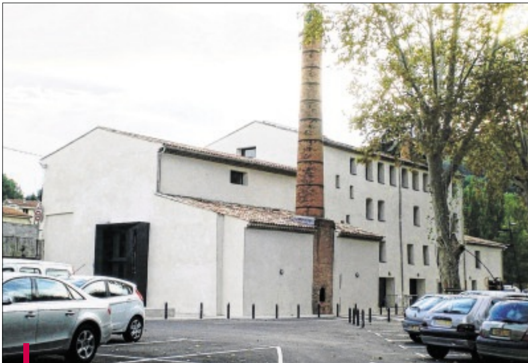
L'espace Plumier rénové abrite depuis peu la police municipale et la bibliothèque Marie-Rose Poggio. Les habitants se demandent ce qu'il en sera des anciens locaux. / PHOTO E.P.
